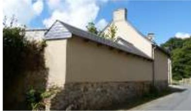
Proscrire les enduits avec du ciment pour remplacer les enduits à la terre
