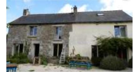
Proscrire les élargissements d'ouvertures et les appuis béton
