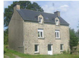
Impact de l'élargissement des ouvertures et des menuiseries en pvc blanc
