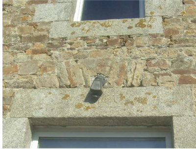
Arc de décharge – Poul an Piliou
