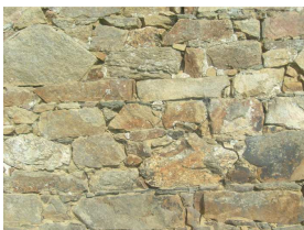
Détails d'une maçonnerie de pierres et mortier
