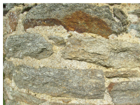
Détails d'une maçonnerie de pierres et mortier
