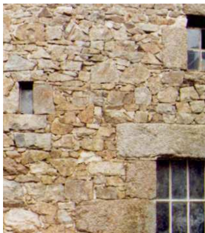
Moellons de granit
