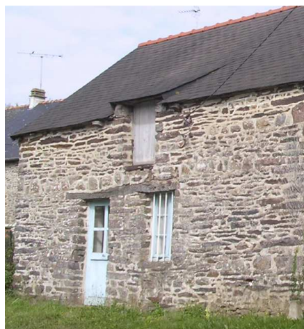
Menuiserie de couleur bleu clair avec une porte d'un seul battant. Menuiserie pleine de la gerbière Barreau à la fenêtre
