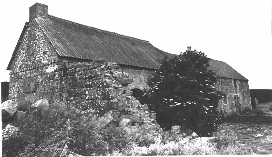
78.22.238 Z - Vue du pignon Sud du bâtiment à arcades
