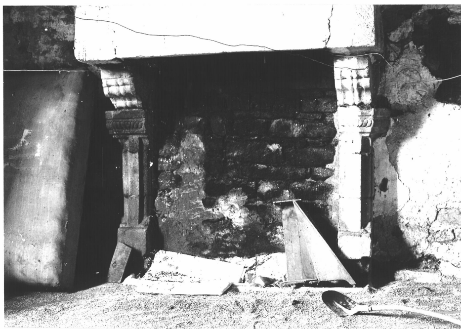
78.22.118 Z - Cheminée du premier étage
