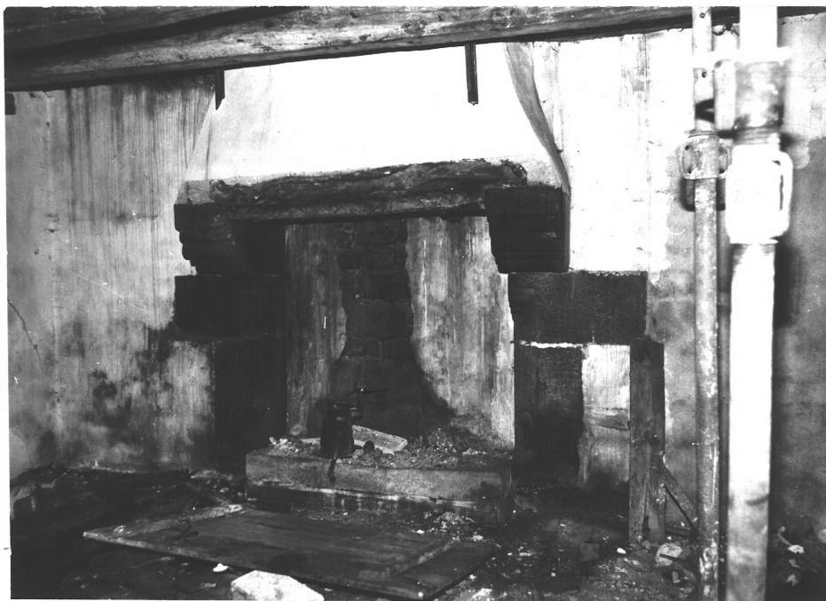
78.22.219 Z - Logis B. Cheminée du premier étage.
