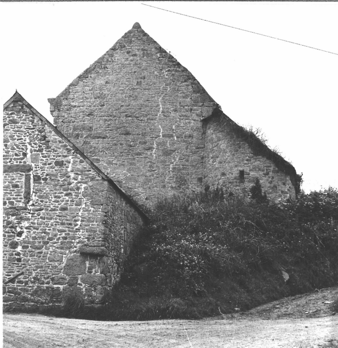
78.22.122 Z - Vue générale du pignon
