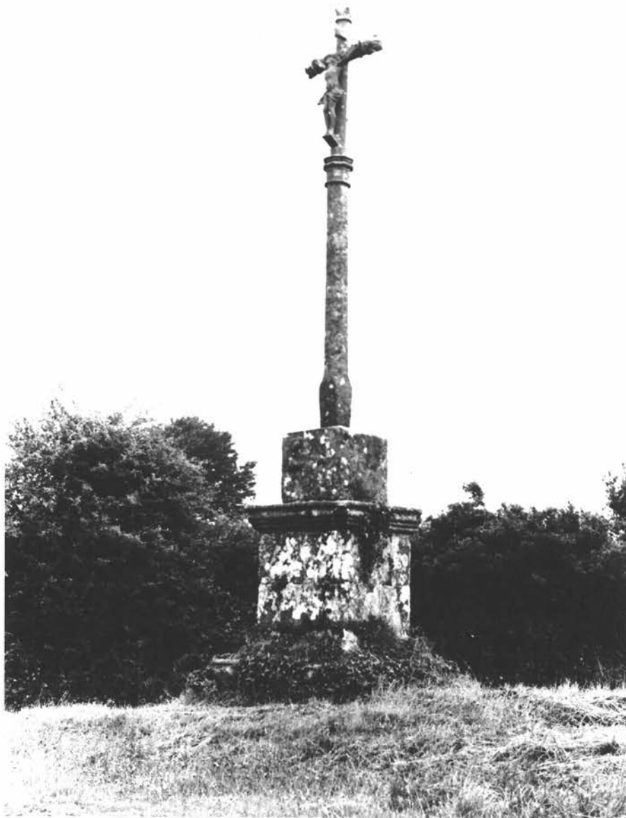
78.22.98 Z - Vue générale prise de l'Ouest
