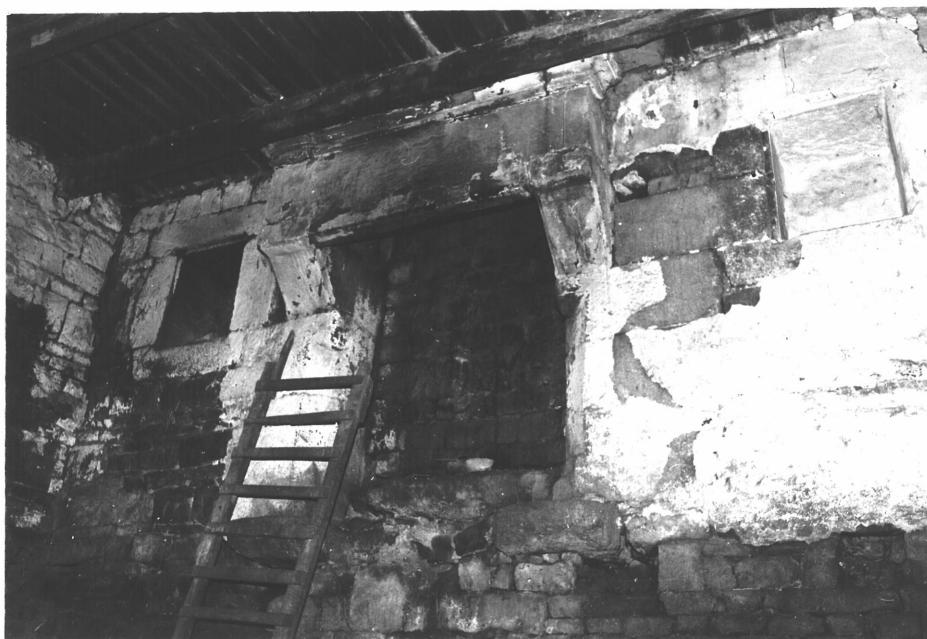
78.22.253 Z - Vue de la cheminée (dans mur-pignon droit) de la maison C.
