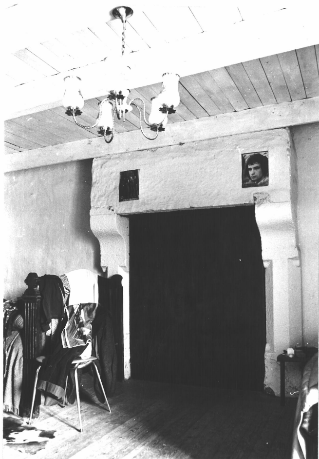
78.22.227 Z - Cheminée du 1er étage
