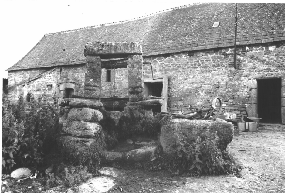
67.22.92 Z - Puits dans la cour.
