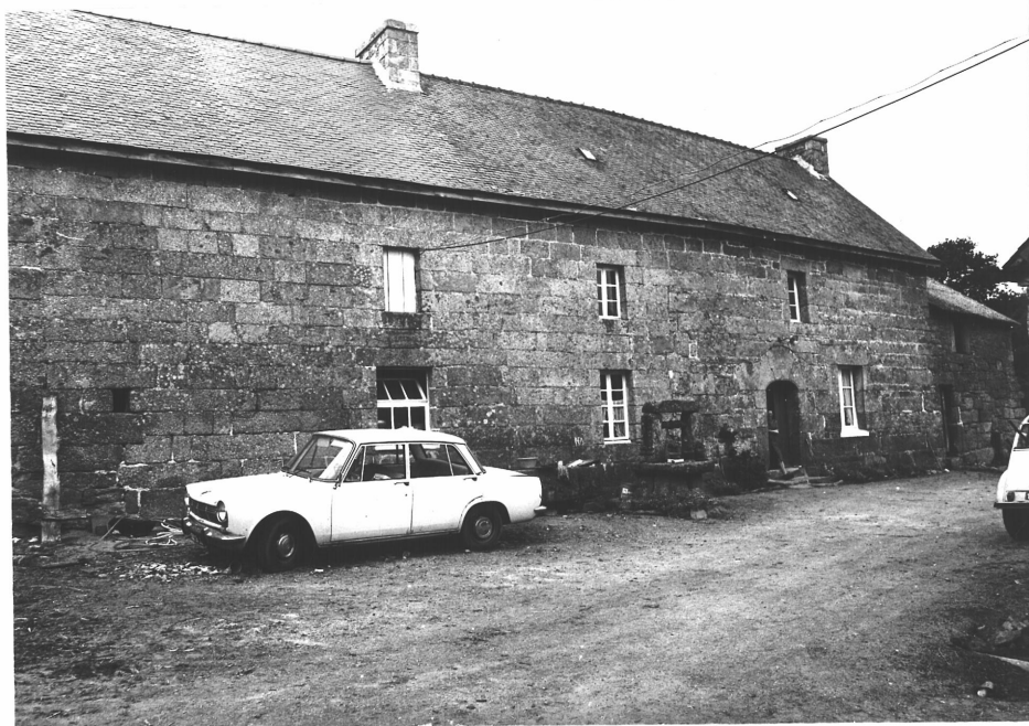
78.22.132 Z - Vue générale de l'alignement.
