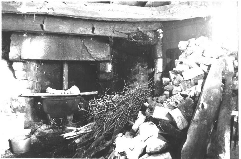
78.22.262 Z - Cheminée et à droite, noyau de l'escalier en vis.
