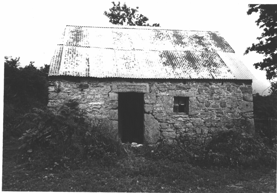
78.22.211 Z - Maison B Vue de l'élévation Sud.
