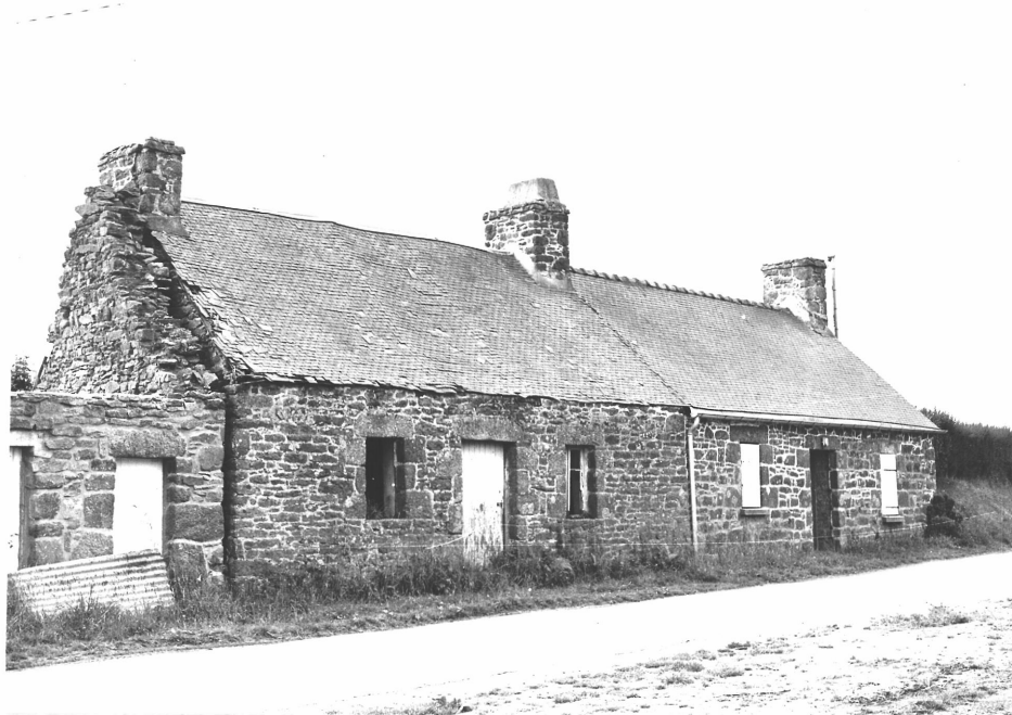
78.22.208 Z - Vue générale de l'alignement.
