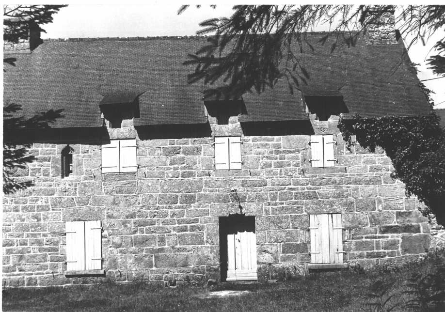
78.22.282 Z - Vue de l'élévation antérieure.
