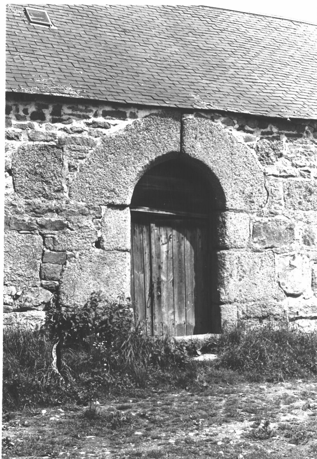
78.22.279 Z - Porte ouvrant le bâtiment de dépendances.
