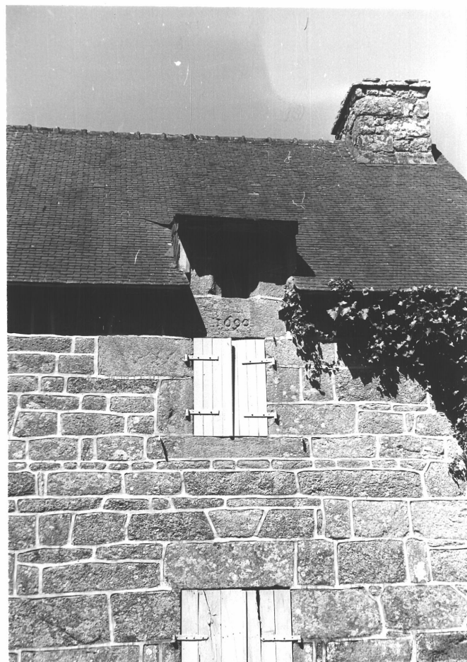
78.22.283 Z - Détail du linteau daté 1690
