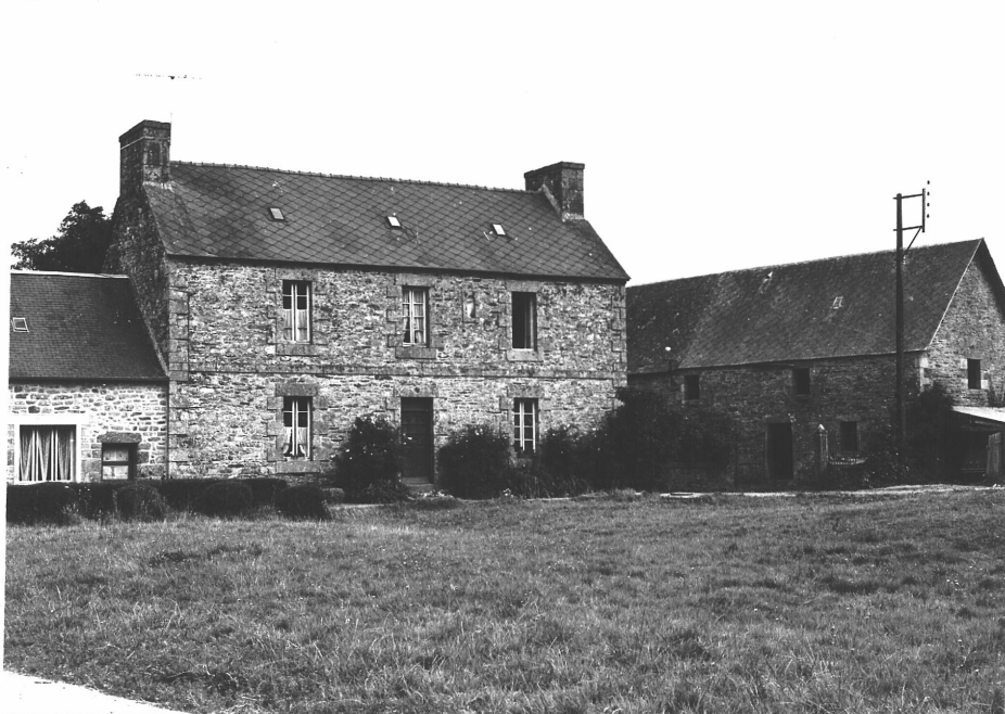
78.22.367 Z - Maison du XIX e siècle, élévation antérieure.
