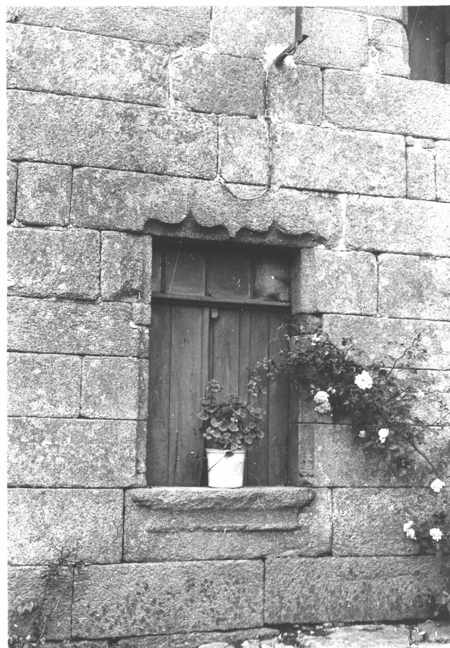
78.22.167 Z - Fenêtre de l'élévation antérieure.
