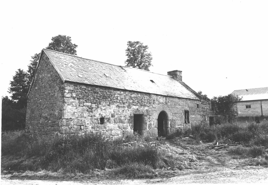
78.22.260 Z - Vue générale des bâtiments.
