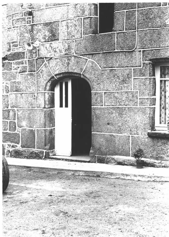
78.22.228 Z - Détail de l'appareil entre le logis et l'étable accolée.
