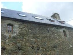
Impact de la multiplication des châssis de toit
