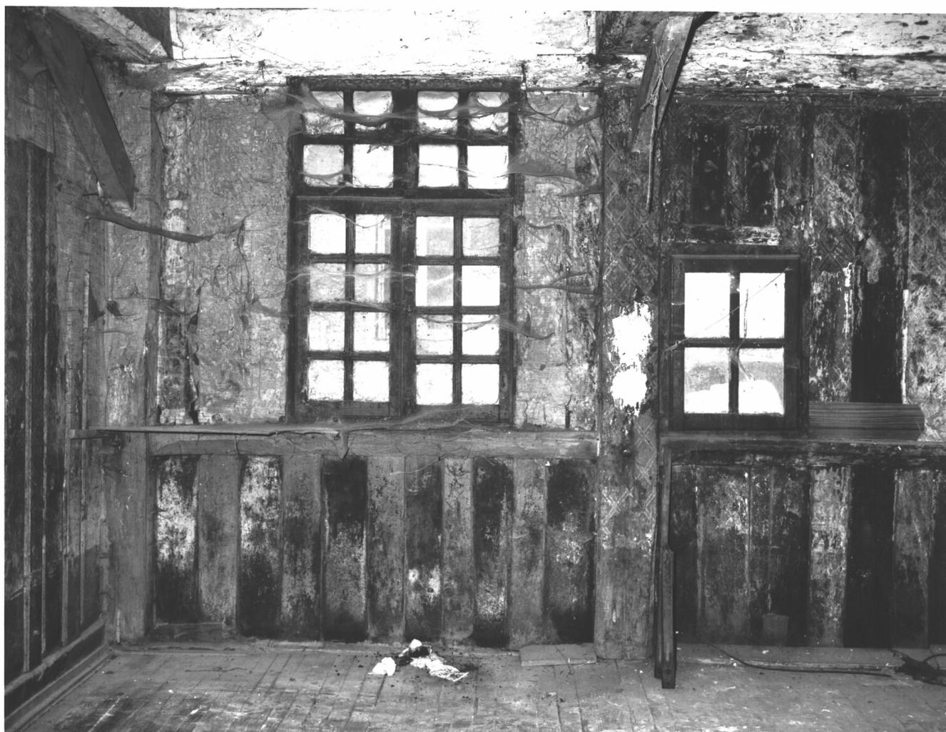
Fig.7 Premier étage, pièce est, détail de la mise en oeuvre des planches.
