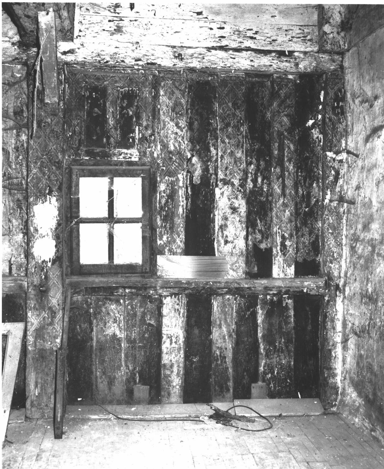
Fig.8 Premier étage, pièce est, détail de la mise en oeuvre des planches
