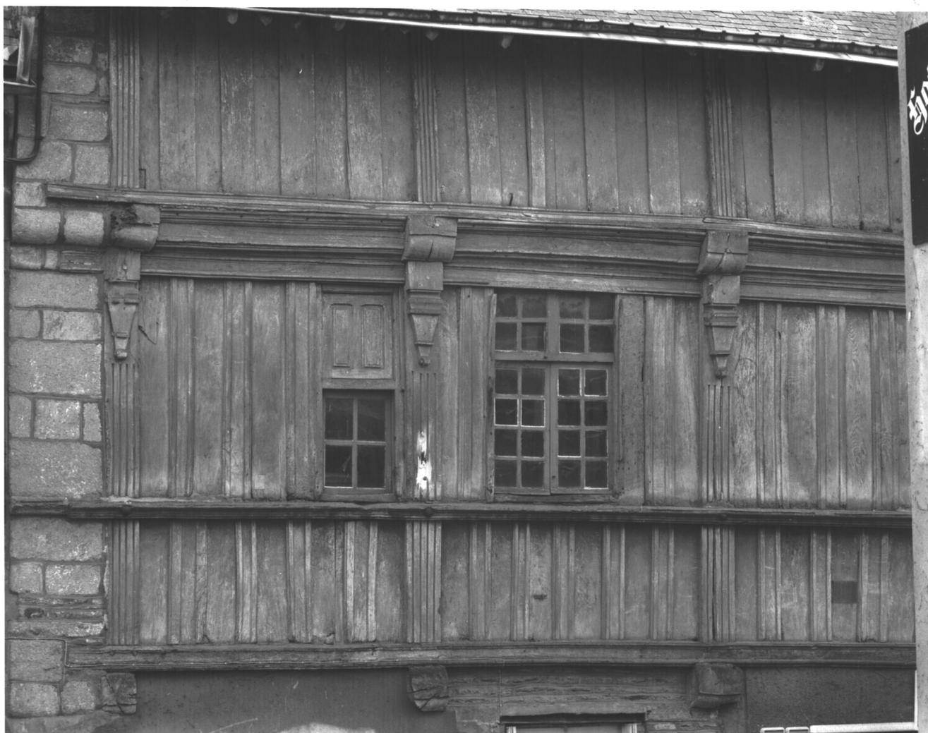
Fig.6 Premier étage, pièce est, détail de la mise en oeuvre des planches.
