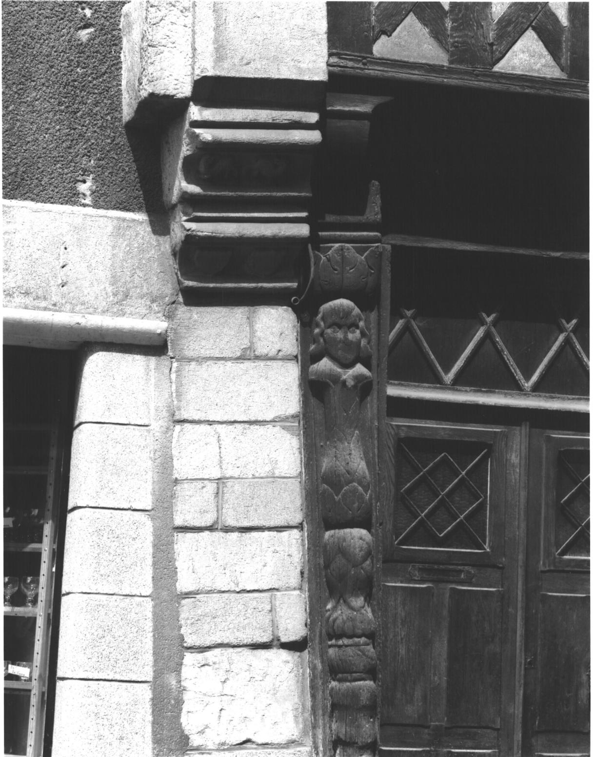
Fig.4 Rez-de-chaussée, détail poteau cornier droit.
