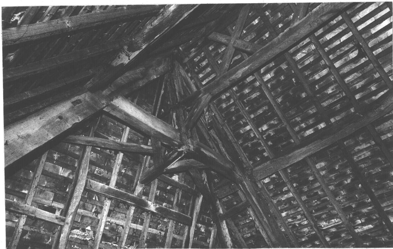
Fig. 35 GUER. Maison n°5 portant la date 1658. Charpente à étrésillonnement mixte (croix de Saint-André et décharges). Cliché n° 81.56.211 Z
