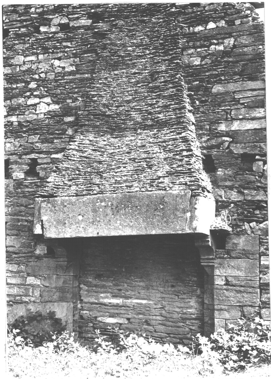
Fig. 30 MONTENEUF. Bécihan; cheminée d'une maison ruinée en schiste et grès (XVIIe ?). Cl. 77.56.547 X
