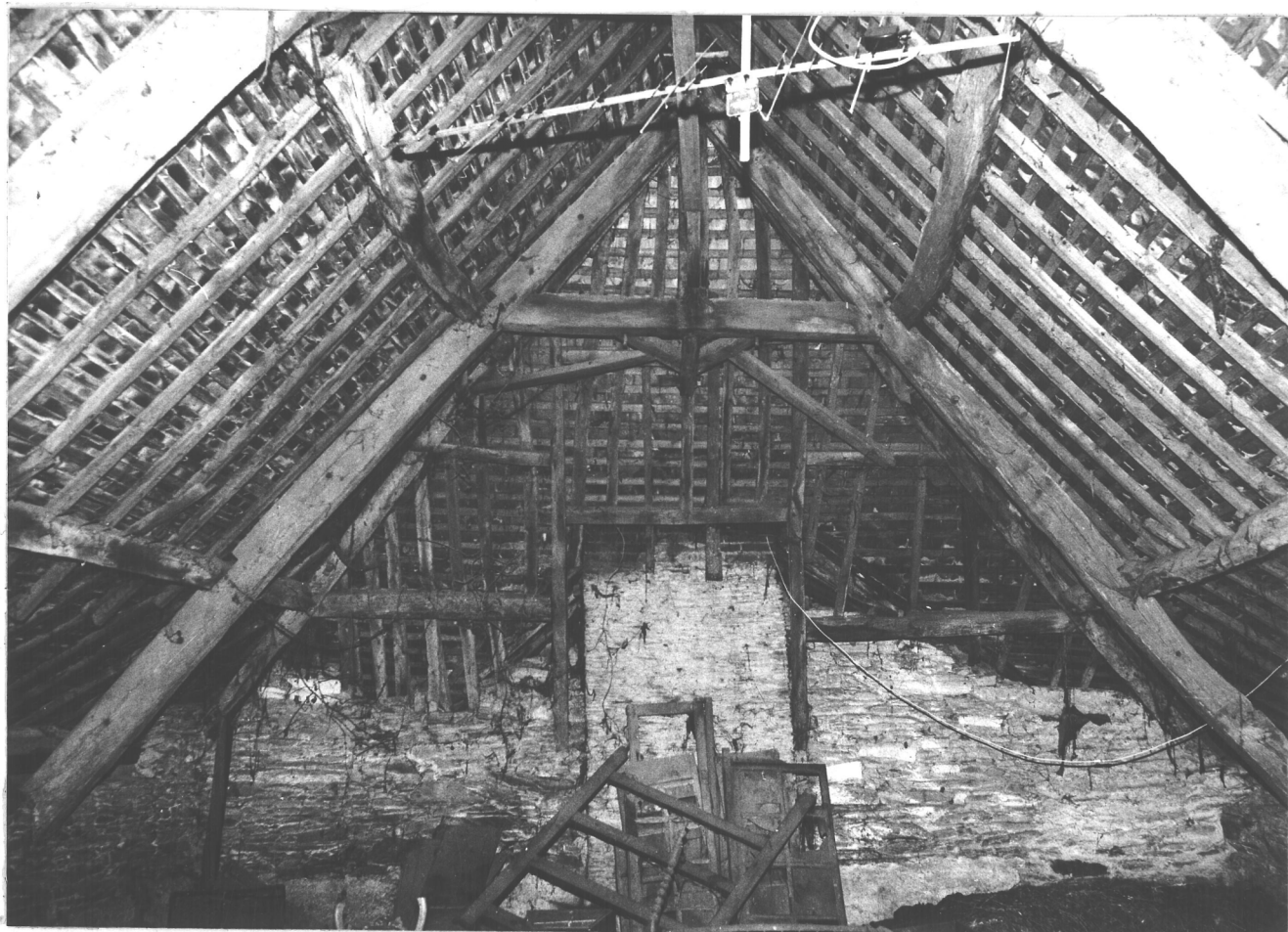
Fig. 34 GUER. Maison n° 5, portant la date 1658. Charpente d'une toiture à croupe et du type à faux-entrait. Cliché n° 8I.56.209 Z
