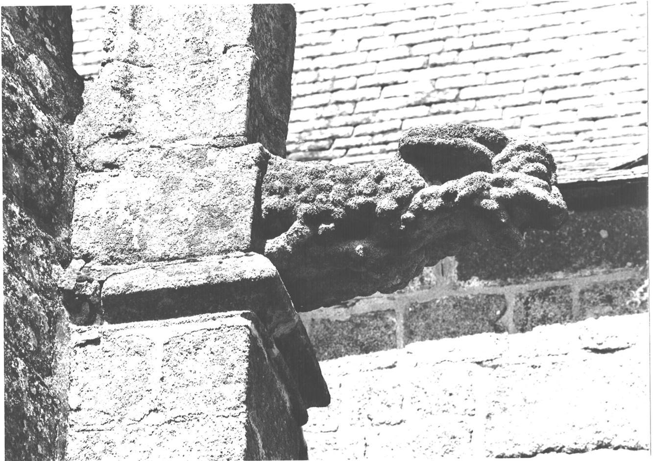
Fig.40 Elévation Sud : détail de crossette
