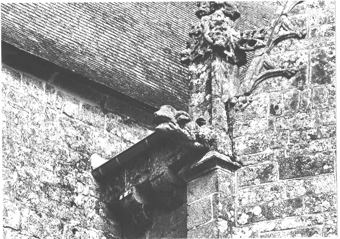
Fig.42 Elévation Sud : détail de crossette
