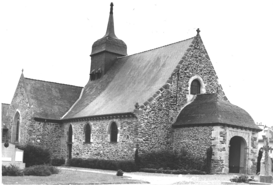
11/6 - L'église vue du Nord-Ouest.
