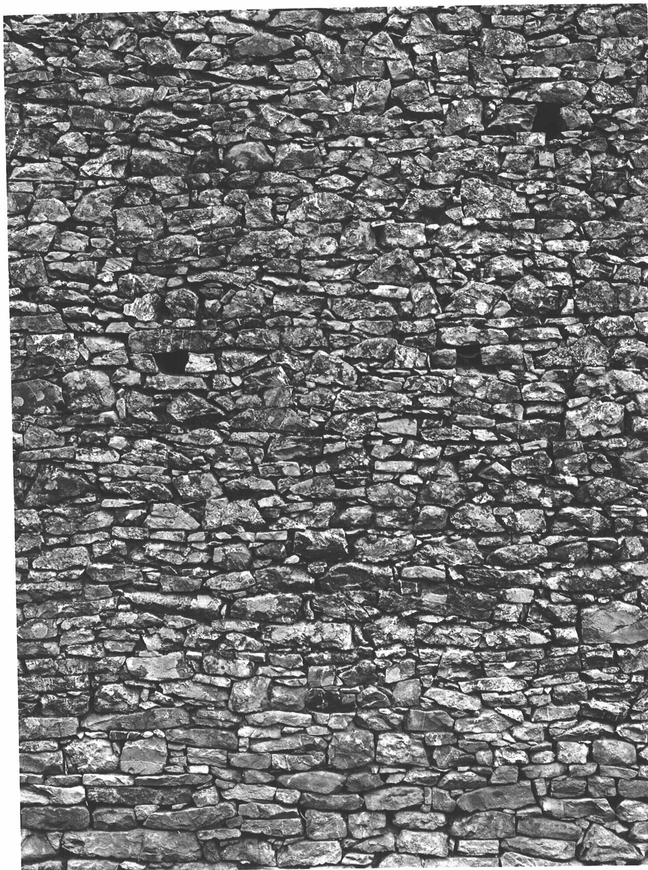
Fig.1 Maison au village, détail d'appareil de grès
