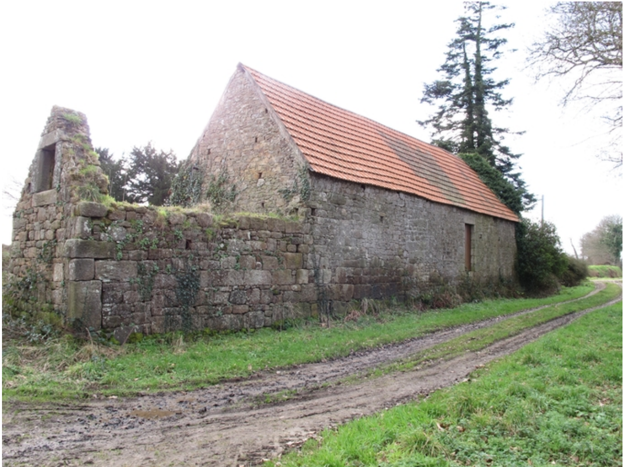
Plouaret, Kerbest : grange à pilier, élévation postérieure. A gauche sur la photographie, jambage du portail
