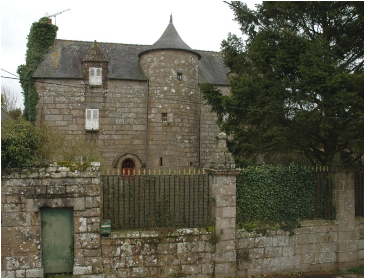
Trégrom, le bourg : manoir de Pen-ar-Guer, élévation antérieure orientée vers l'ouest-nord-ouest, tour circulaire en demi-hors-oeuvre en façade antérieure abritant un escalier en vis
