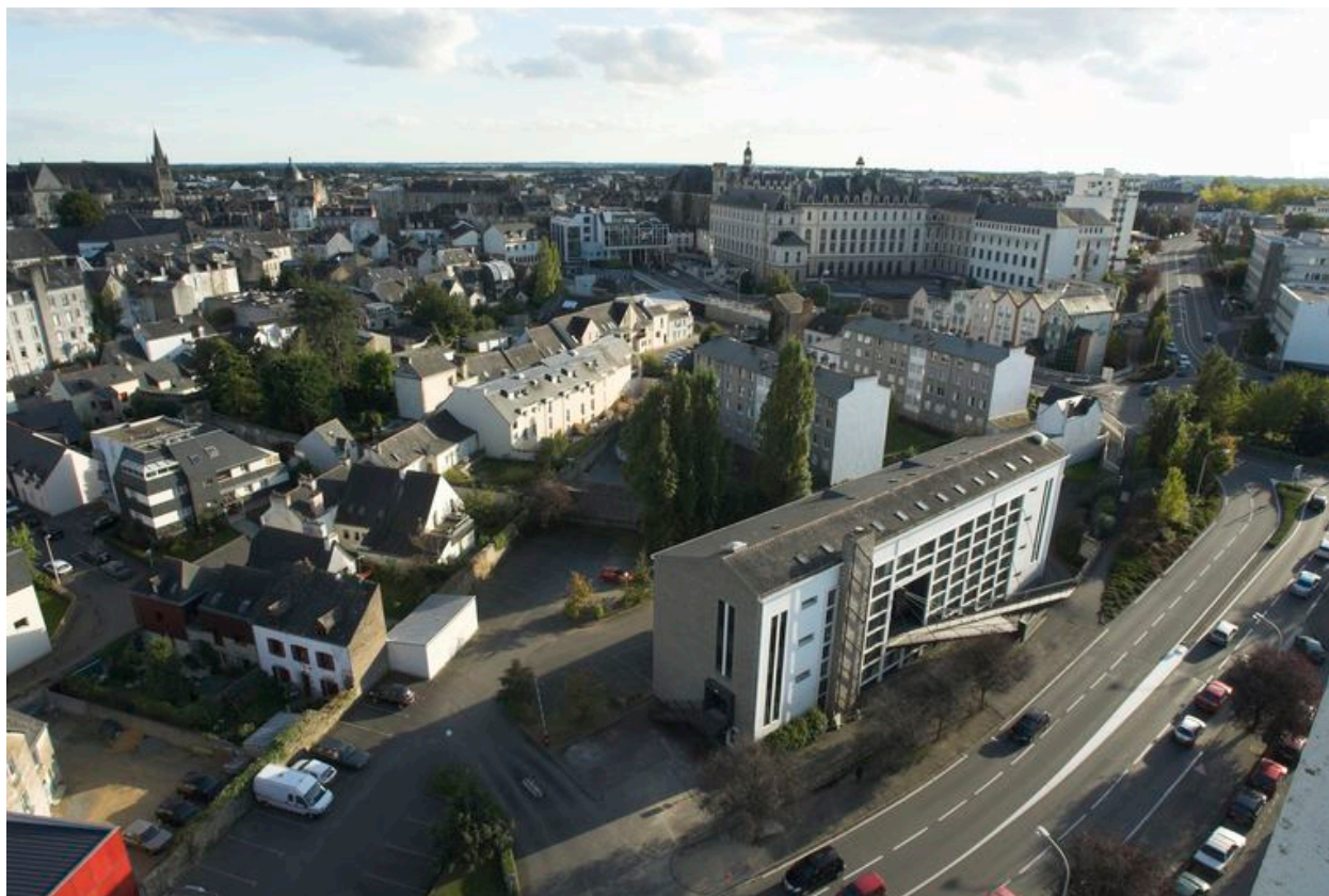
Vue générale prise depuis l'immeuble de la Sécurité sociale.
