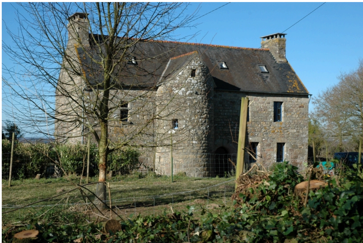
Trégrom, Pabu : manoir, élévation antérieure orientée vers le sud
