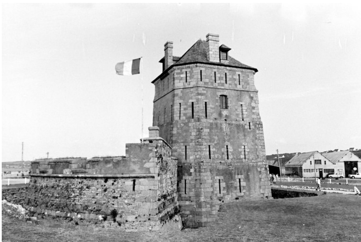
Vue générale de la tour Vauban en 1969
