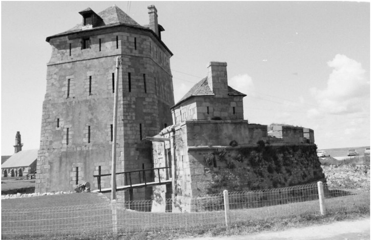
Vue de la tour Vauban en 1967
