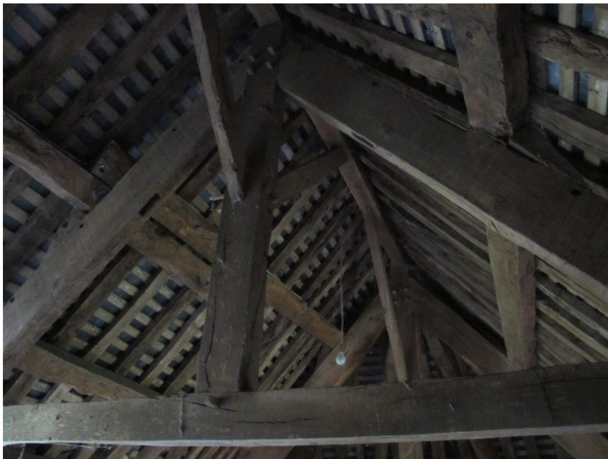
Le Vieux-Marché, Goaz Froment : manoir, vue intérieure, charpente
