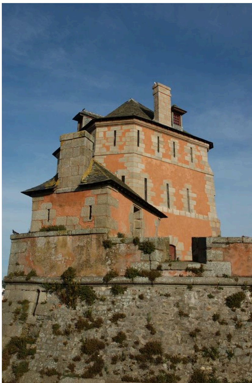
Vue de la tour Vauban après restauration (août 2007)
