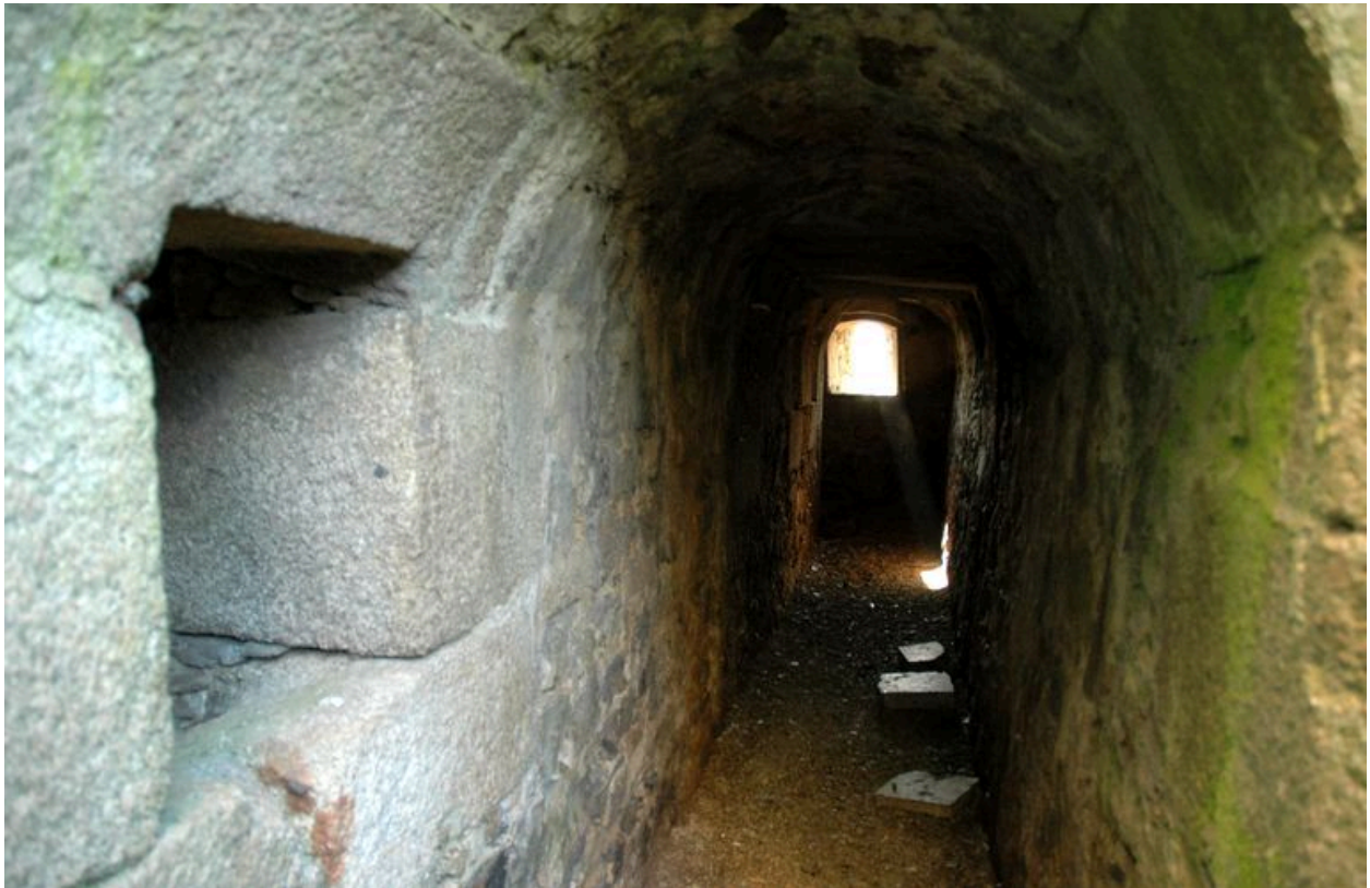
Vue de la galerie de fusillade
